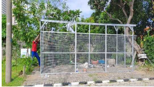
Gambar 6 Tampak Barat bangunan screen house
