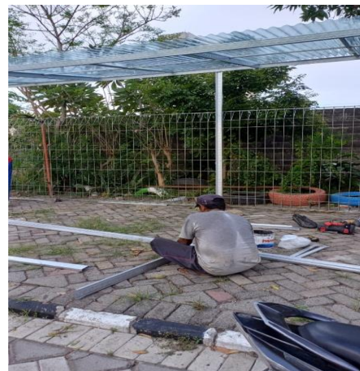
Gambar 4 Pembangunan konstruksi screen house
