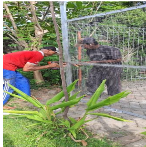
Gambar 5 Penutup dinding samping dan belakang screen house
